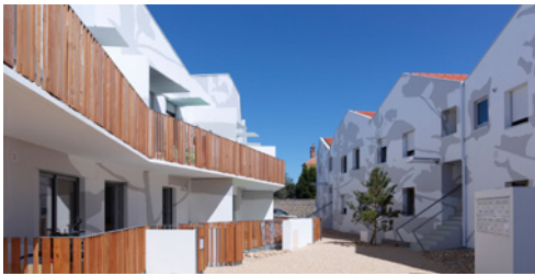
Toiture tuiles Vincent Couverture / Résidence Mervaux, Saint Gilles Croix de Vie (Architecte : TETRARC)
