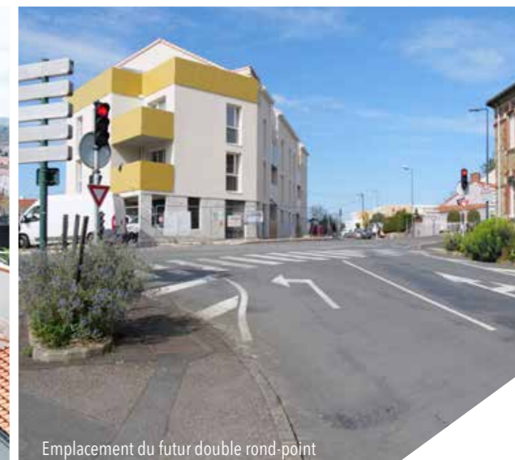
Rue d'Anjou avant travaux
