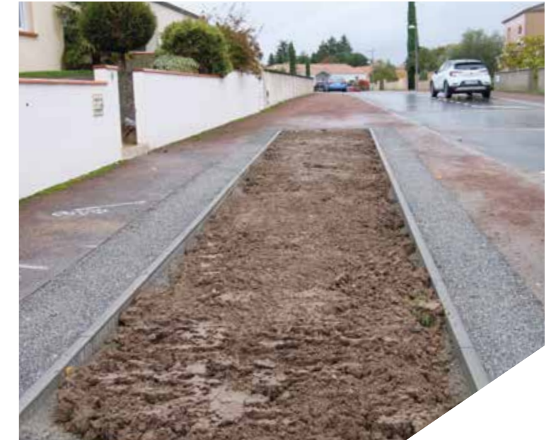
Aménagement rue du Clos Julienne
