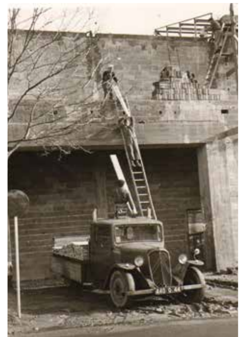
1961 - L'entreprise Grégoire monte la volige sur la charpente métallique
