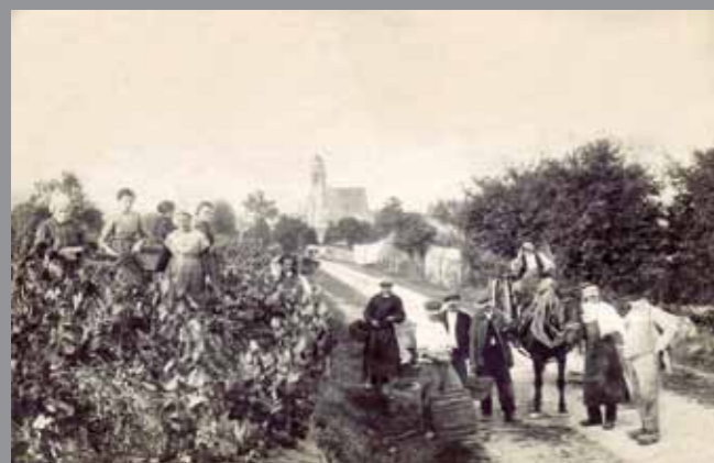
Rue saint Christophe - Photo Cesbron
