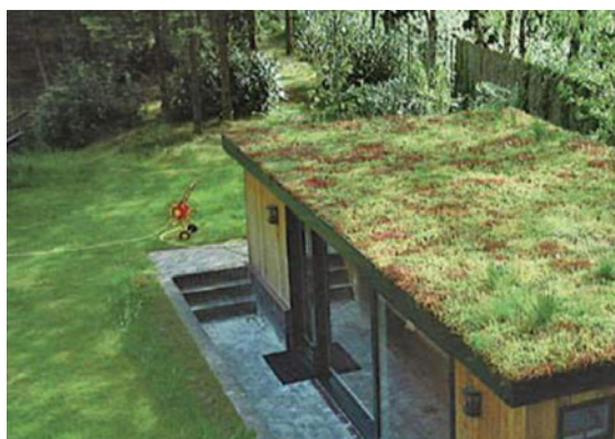
Toiture végétalisée : la végétalisation permet de redonner en espace vert la surface d'emprise au sol bâtie et de réduire ainsi l'imperméabilisation des sols. Elle renforce l'isolation acoustique et thermique, elle absorbe une partie des eaux pluviales et limite les débits au niveau des réseaux.
