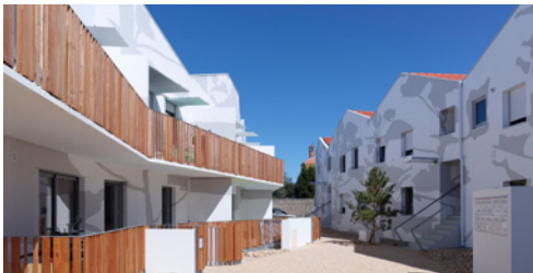
Toiture tuiles Vincent Couverture / Résidence Mervaux, Saint Gilles Croix de Vie (Architecte : TETRARC)
